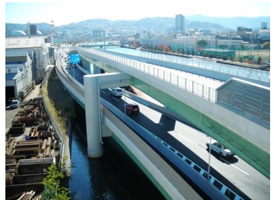
写真 2-1 ダブルデッキ構造の様子
