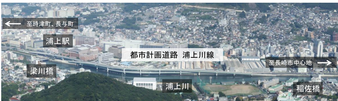
写真 1.2-1 遠景より浦上川線を望む
