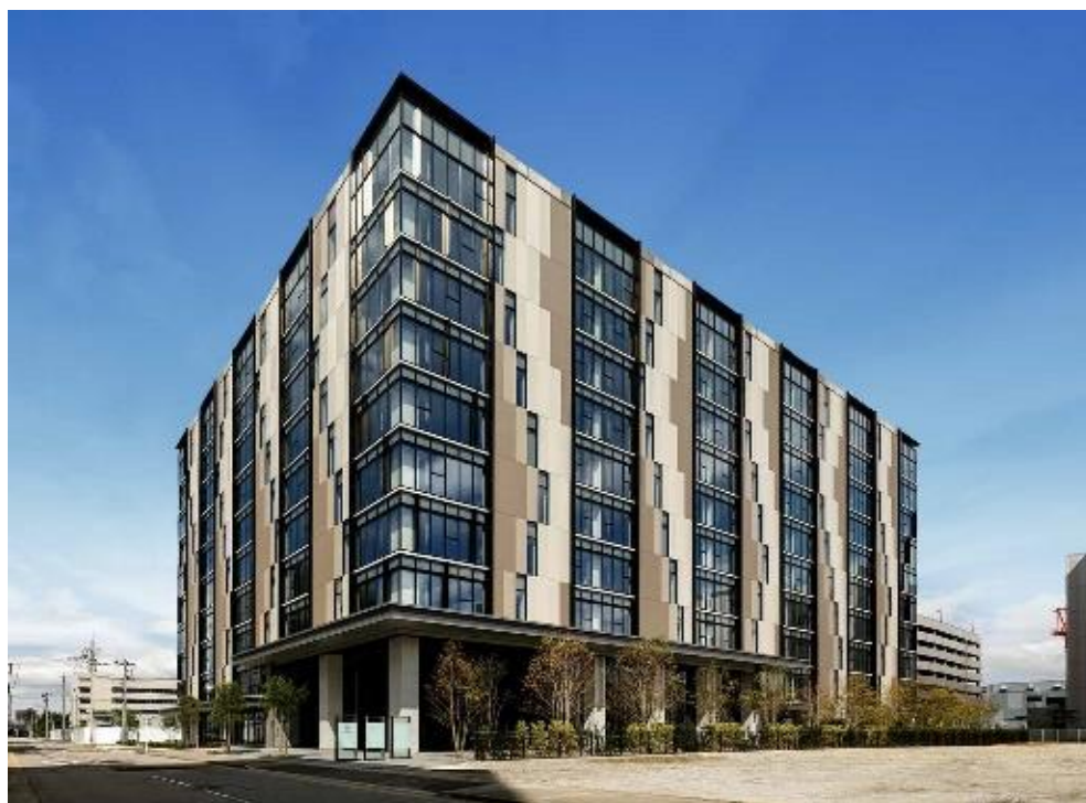
DMG MORI ACADEMY 金沢 外観(ビル全体) ※本ビルの1階部分にDMG MORI ACADEMY 金沢があります
