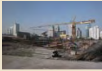
新館建設現場
