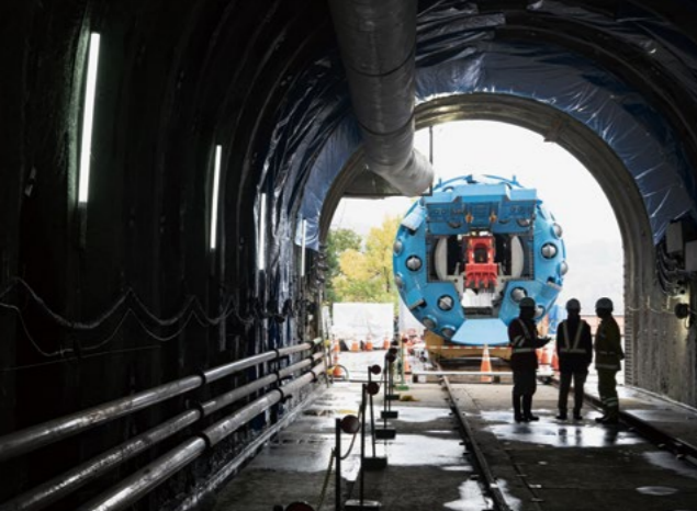
新たに開発された「NATBM掘削機」。不良地山でのNATMモードでは、前部の赤い「バケット式掘削機」を使用し、安定掘進する。
