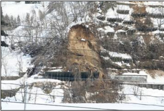
写真 5—14 土砂崩落 （津南町田中：津南町提供）
