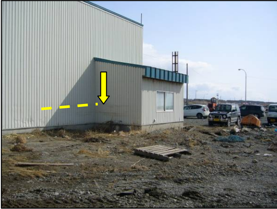
写真 5-6 津波の痕跡 （むかわ町鷗川漁港、表 1 の 13）
