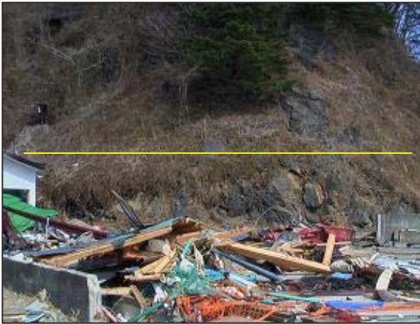
写真 5-11 津波の痕跡 （宮古市日立浜町、表 2 の 24）
