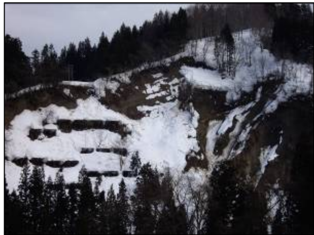
写真 5—20 土砂崩落（十日町市松之山赤倉）
