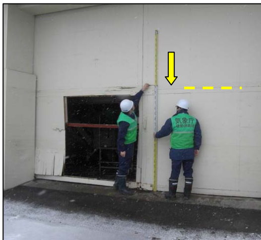
写真 5-4 津波の痕跡 （広尾町十勝港、表 1 の 8）
