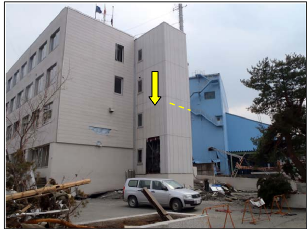
写真 5-12 津波の痕跡 （釜石市魚河岸町、表 2 の 27）
