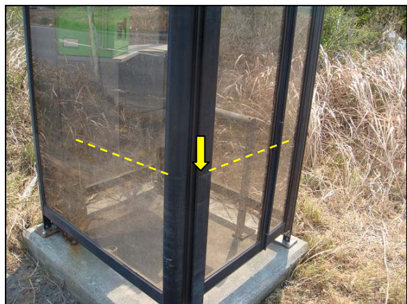
写真 5-24 津波の痕跡 (鉾子市外川漁港、表 3 の 57)
