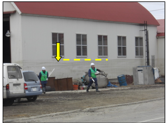
写真 5-3 津波の痕跡 （豊頃町大津漁港、表 1 の 7）
