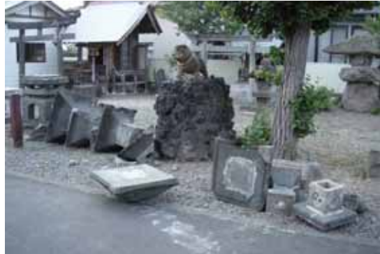
加茂神社境内の石灯籠（高さ約2m）。この石灯籠のみ南側に倒れている。奥の鳥居などに損傷は見られない。
