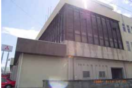
震度計が設置されている古川消防署の建物に被害は見られない。
