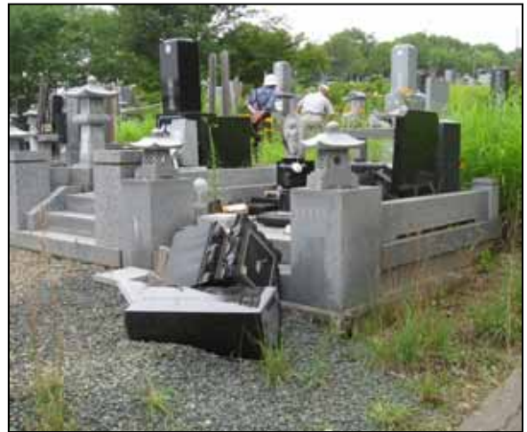
墓石の倒壊（全体の約 1 割が倒壊）
