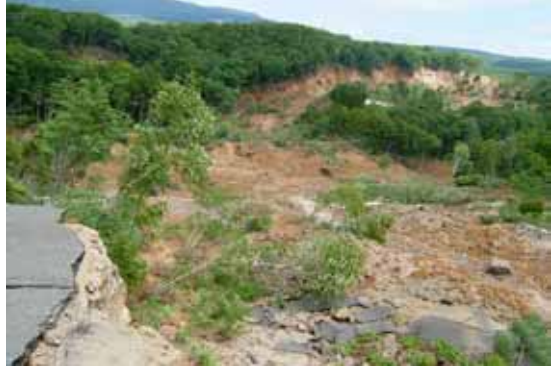
荒砥沢ダム周辺の大規模崩壊。
