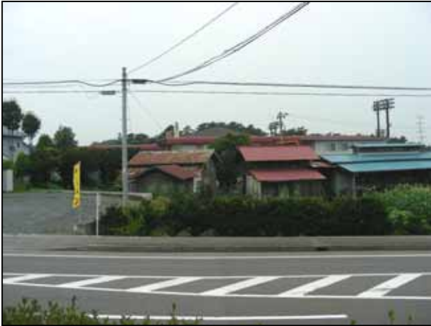
古い木造平屋建ての建物に異常は見られない
