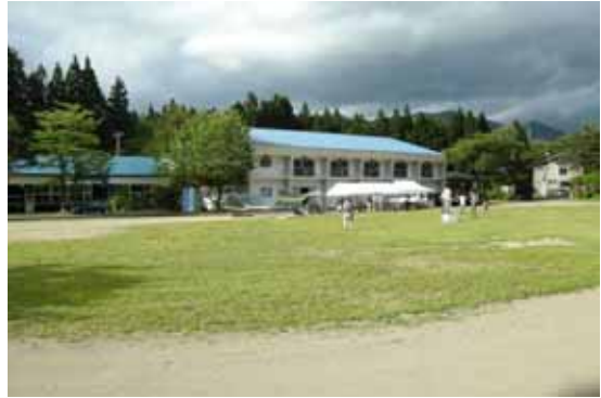
旧鬼首中学校体育館、木造校舎の壁面、窓ガラス等に被害は見られない。
