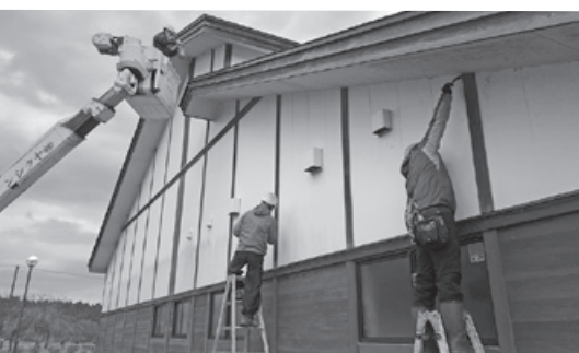
地域交流施設を塗装する様子
