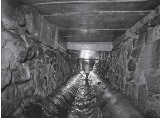
図-5 太閤下水(大阪市建設局提供)
