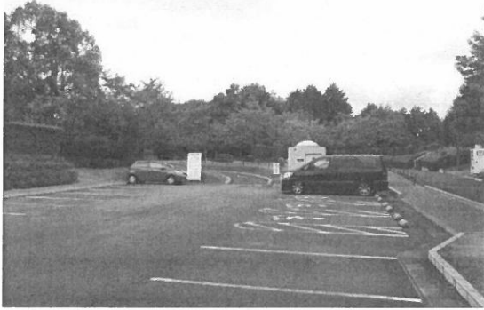
① A 駐車場（入口側から見る）
