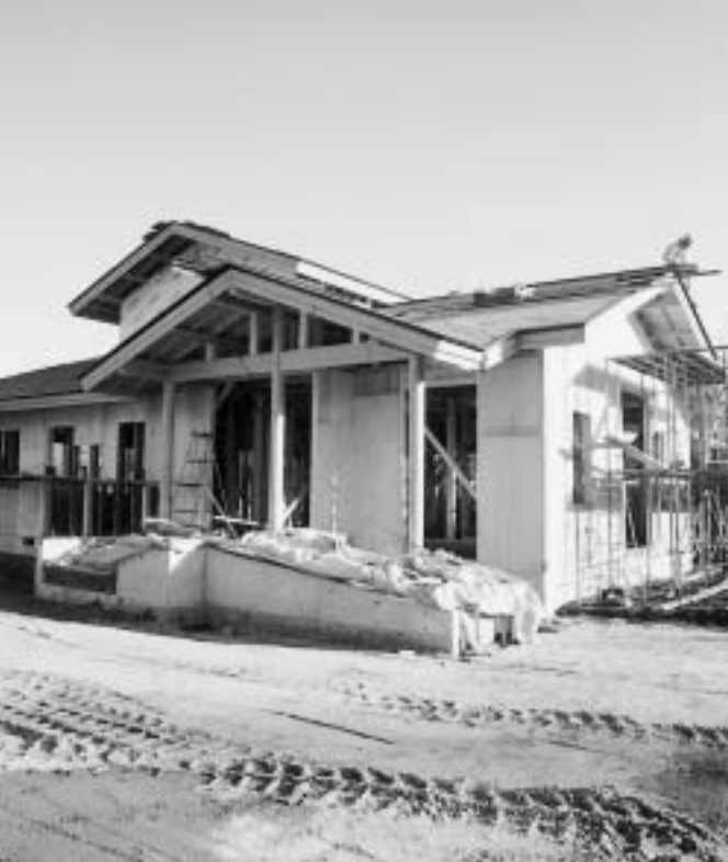
4月の開所に向け、建設が進む菅平の宅幼老所。
