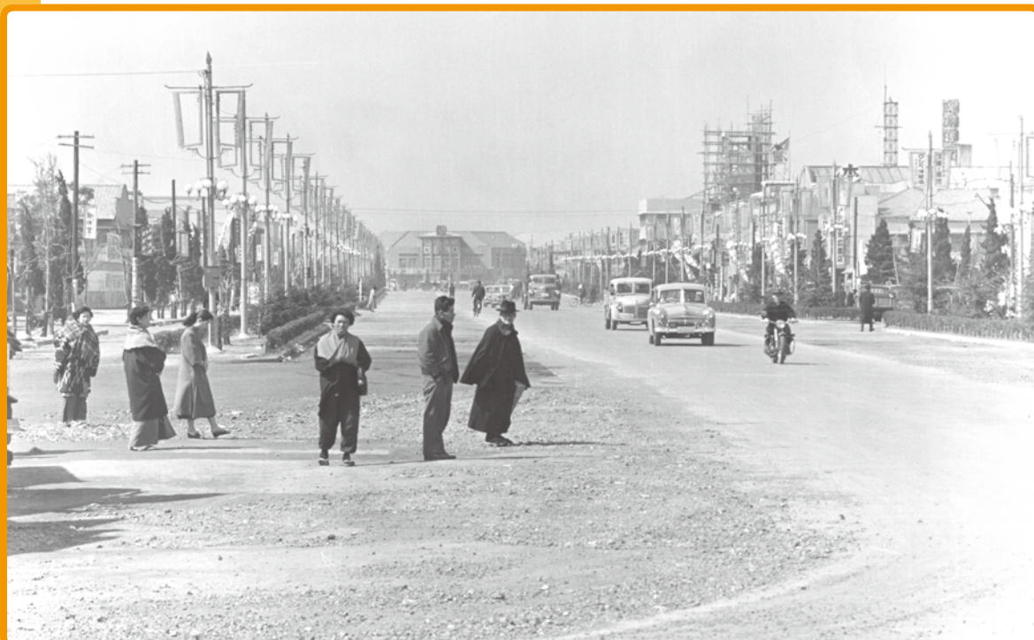
①市役所前付近の国道190号の様子
