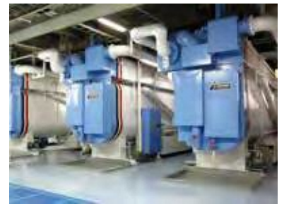
図表218 地域冷暖房施設(吸収式冷凍機)
