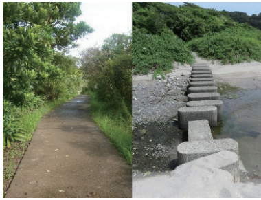
遊歩道の現状
