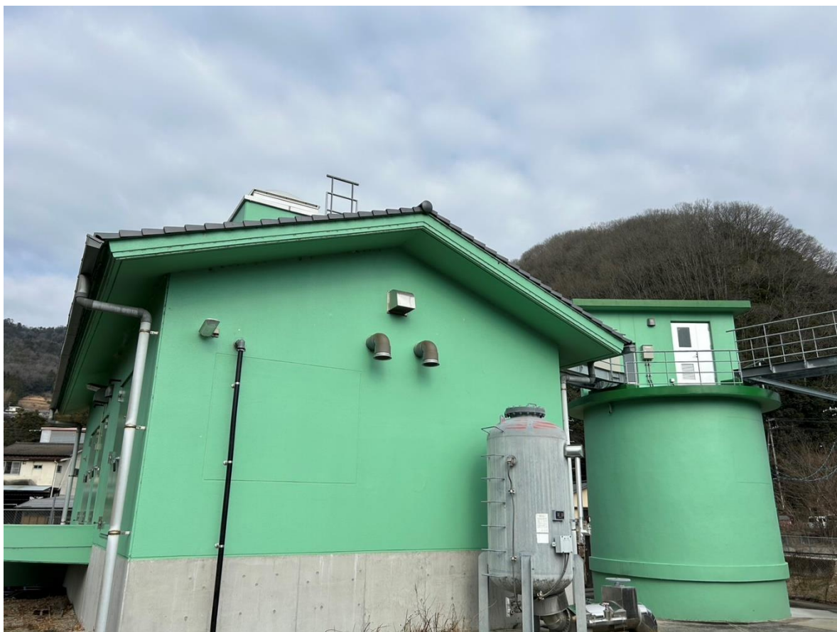
(和田・神崎・陰地配水区(神崎系) 第3水源池)
