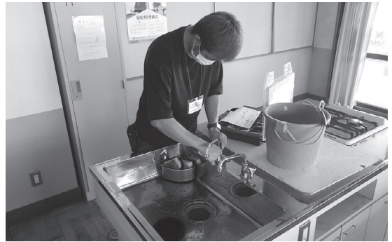
▲上下水道設備の修繕ボランティアの様子
