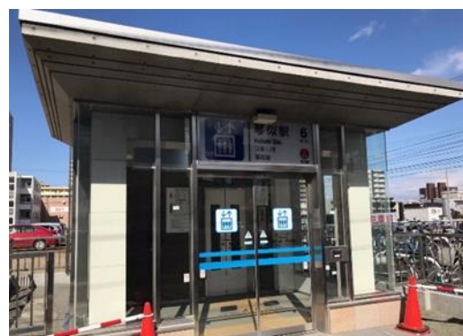
エレベーターの増設（地下鉄琴似駅）
