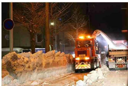
幹線道路の排雪作業の様子
