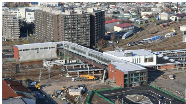
J R 苗穂駅の移転・橋上駅舎化
