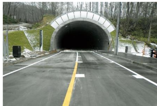
盤溪北ノ沢トンネルの開通
