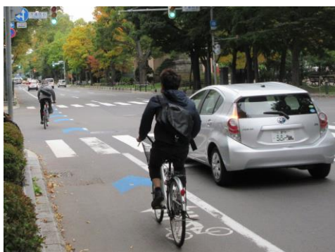
矢羽根型路面表示による自転車通行空間 (大通北線)
