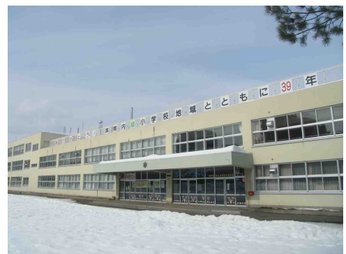
(真駒内緑小学校の外観)
