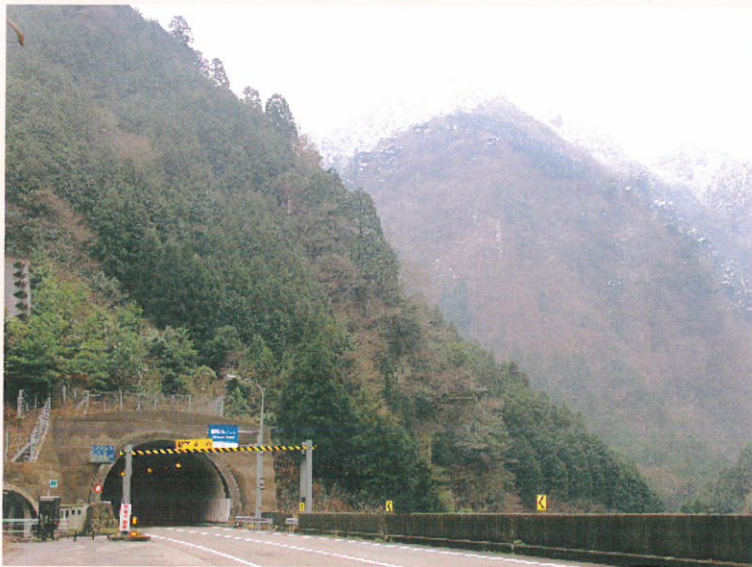
新寒風山トンネル
