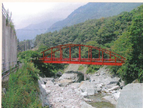
中之池橋・谷川溪谷
