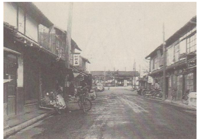
手原駅前 桶文の作業場付近
