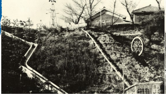
夢のパラダイス(小学校東側の発電施設)(昭和41年)
