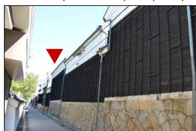
図2-5-22 乾蔵 (明治7年(1874)建築)
