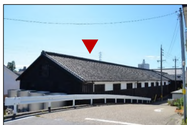
図2-5-18 新甲子蔵 (昭和14年(1939)建築)
