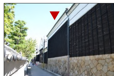
図2-5-23 米蔵 (明治7年(1874)建築)
