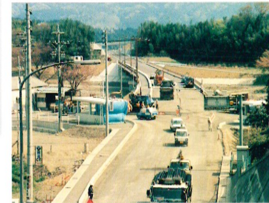
国道365号一之瀬バイパス工事が進む (開通:平成4年8月3日)
