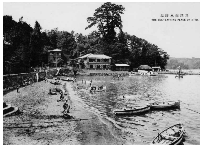
三津久伏の海水浴場 後方の岬に東瀛荘、麓に松濤館
