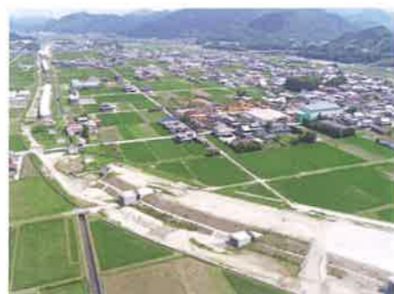
工事の進む津万高架橋
