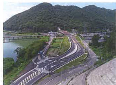
完成した西脇北バイパス大伏ランプ
