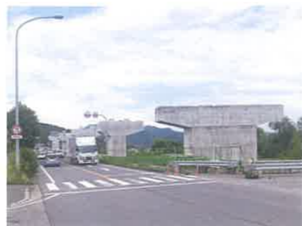
下戸田高架橋区間の整備状況
