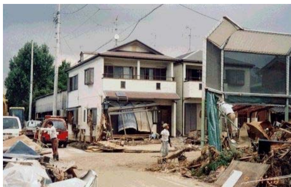
西区あし原町堤防破壊現場付近
