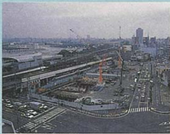
建設中の雨水貯留施設
