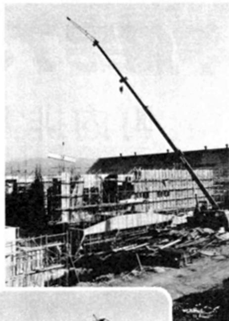
▲大島加圧ポンプ場工事
