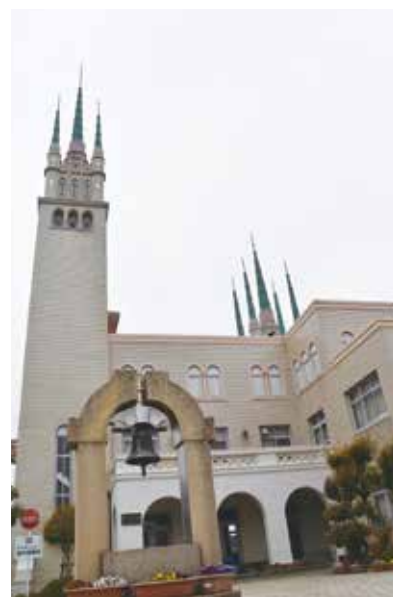
ヤンマー会館
