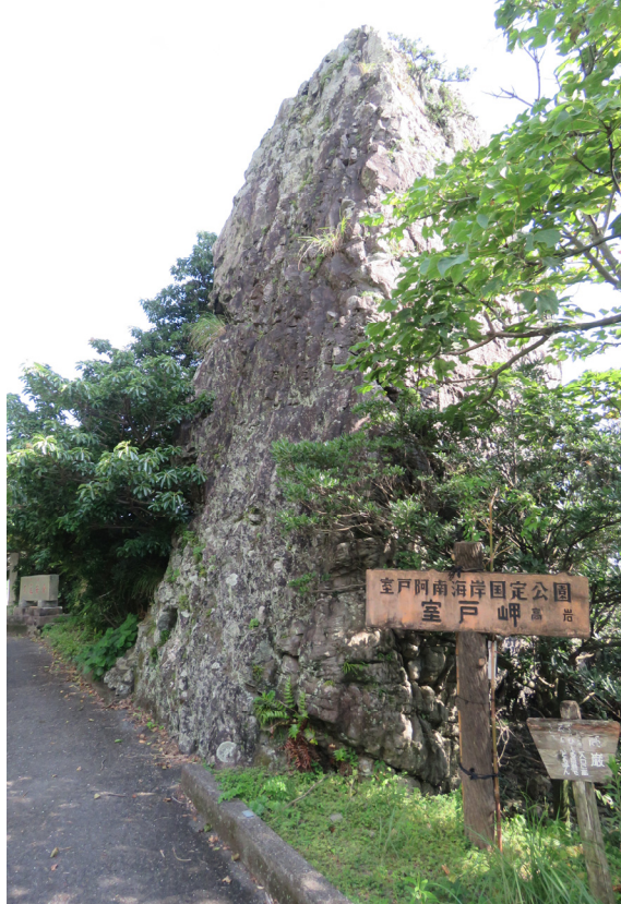
国道の拡幅で一部掘削された高岩
