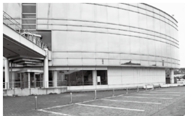
改修するフェリーターミナルビル（室蘭）
