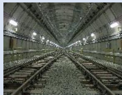
東西線トンネル
