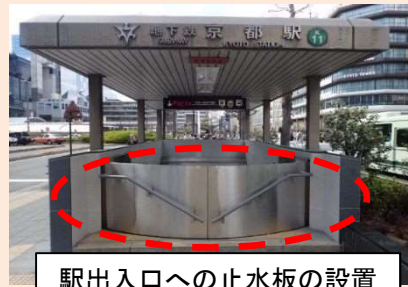
駅出入口への止水板の設置
