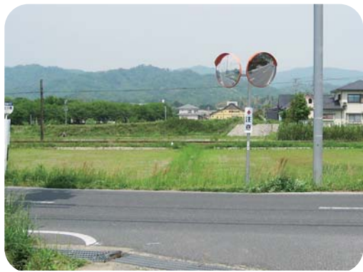
改善されたカーブミラー
