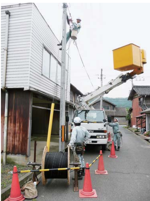
光ファイバの架設工事
