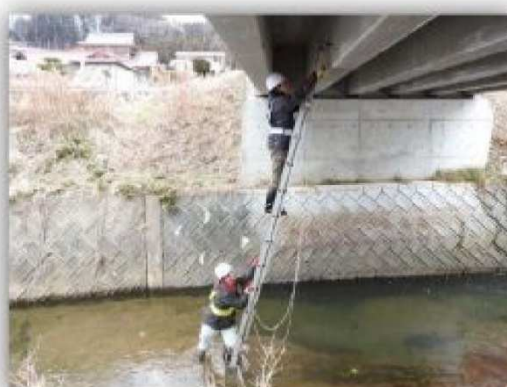
▲梯子使用しての点検
