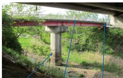
橋脚 主桁 橋台
