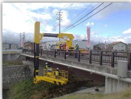
▲橋梁点検車での点検
