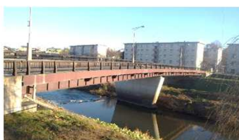
▲予防保全橋梁 ・赤坂橋（橋長 57.3m、幅員 7m）
