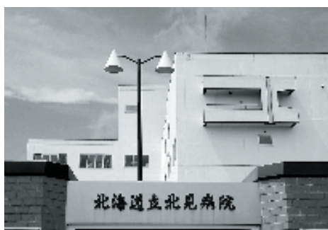
道立北見病院の移転改築は……
