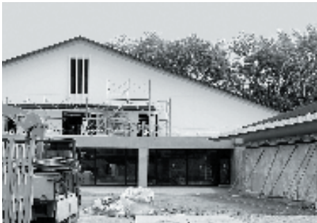
建設中の北見市武道館
