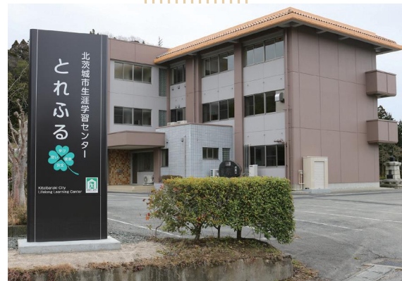
「北茨城市生涯学習センター」は「多彩な学び」と「健康増進」の場であるほか、「災害時における北部地域の防災拠点」の機能もあわせ持っています
