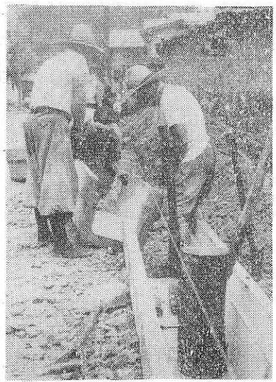
進む道路舗装工事
