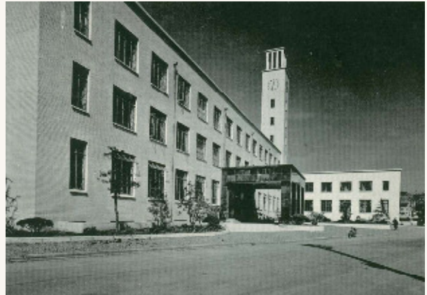
昭和13年 本庁舎竣工時の様子
