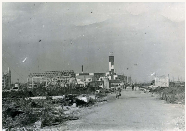
空襲後、焼失を免れた本庁舎 (平和館所蔵)
