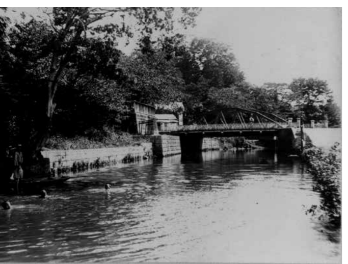
赤間川と高沢橋。明治43年の洪水で石橋が流され鉄橋となった (大正13年頃)
