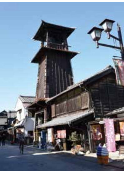
時の鐘耐震化工事の完了 （平成29年）
