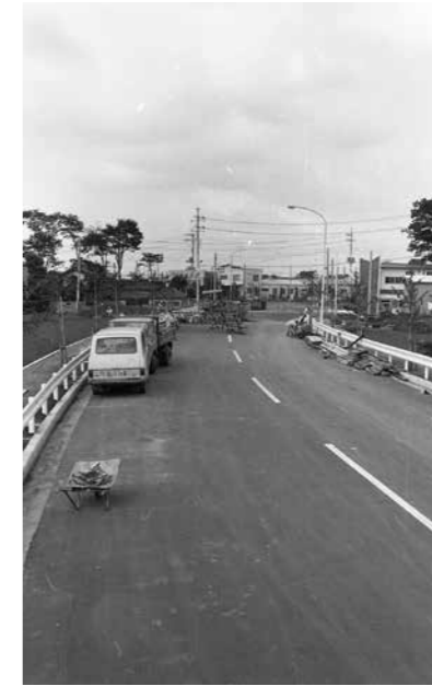
国道16号の一部として川越環状線開通 (昭和49年)
