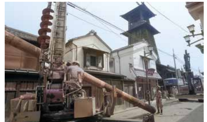
鐘つき通り電線類地中化工事（平成6年頃）
