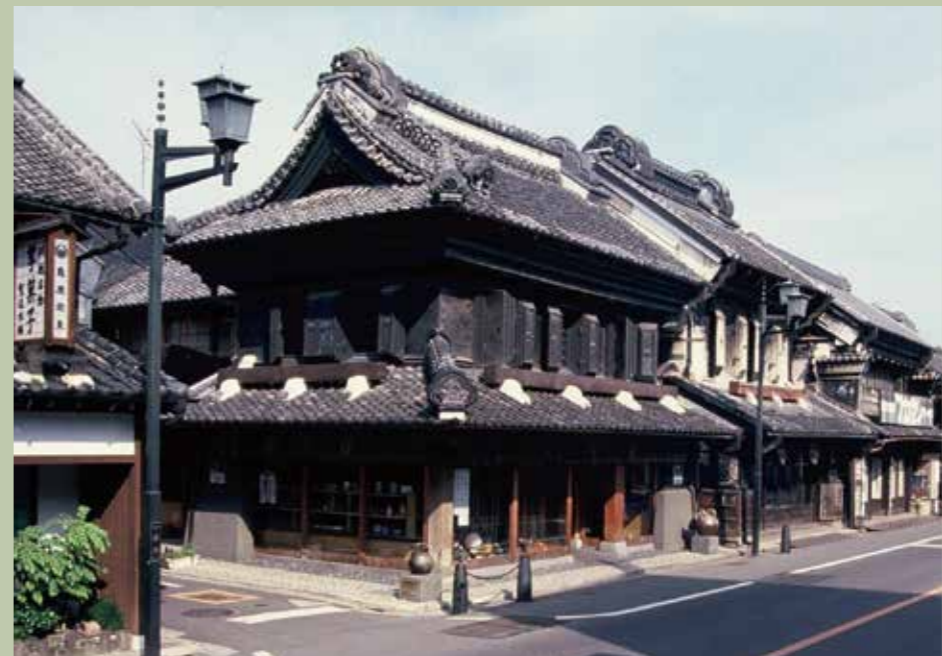
前年に電線類地中化工事が完了した一番街 (平成5年)
