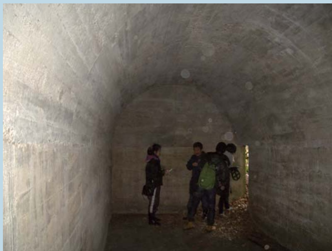
(アーチ状の天井)
