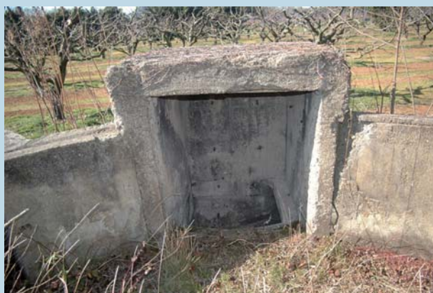
(機銃部から地下 へ降りる昇降口)
