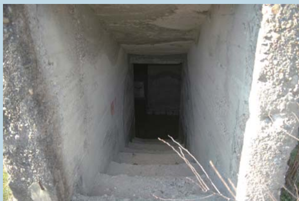
(地上部から地下 へ降りる階段)
