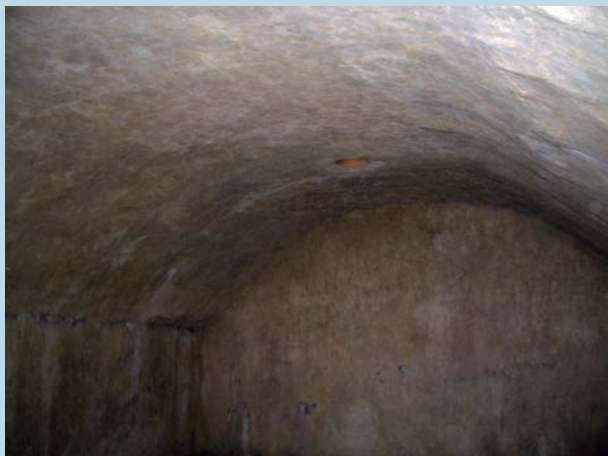
(防空壕の天井はアーチ状を呈し、換気口が設けられている。)
