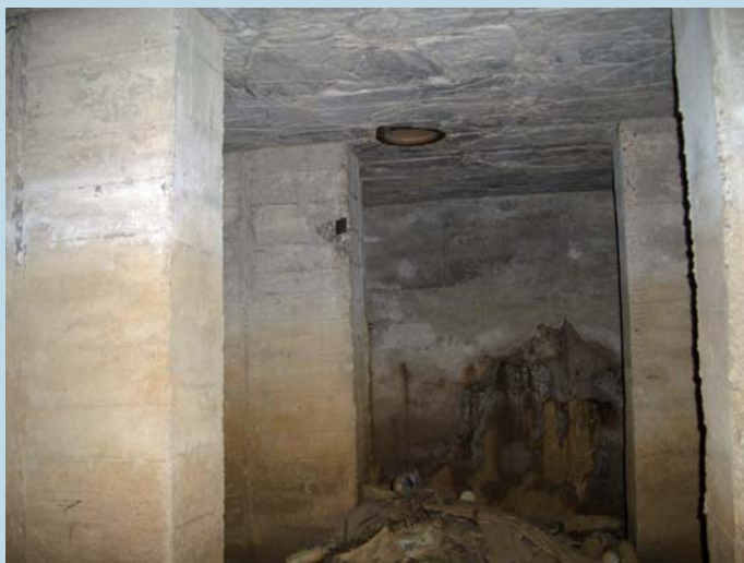
(内部は仕切りがあり小部屋に分割されている。)
