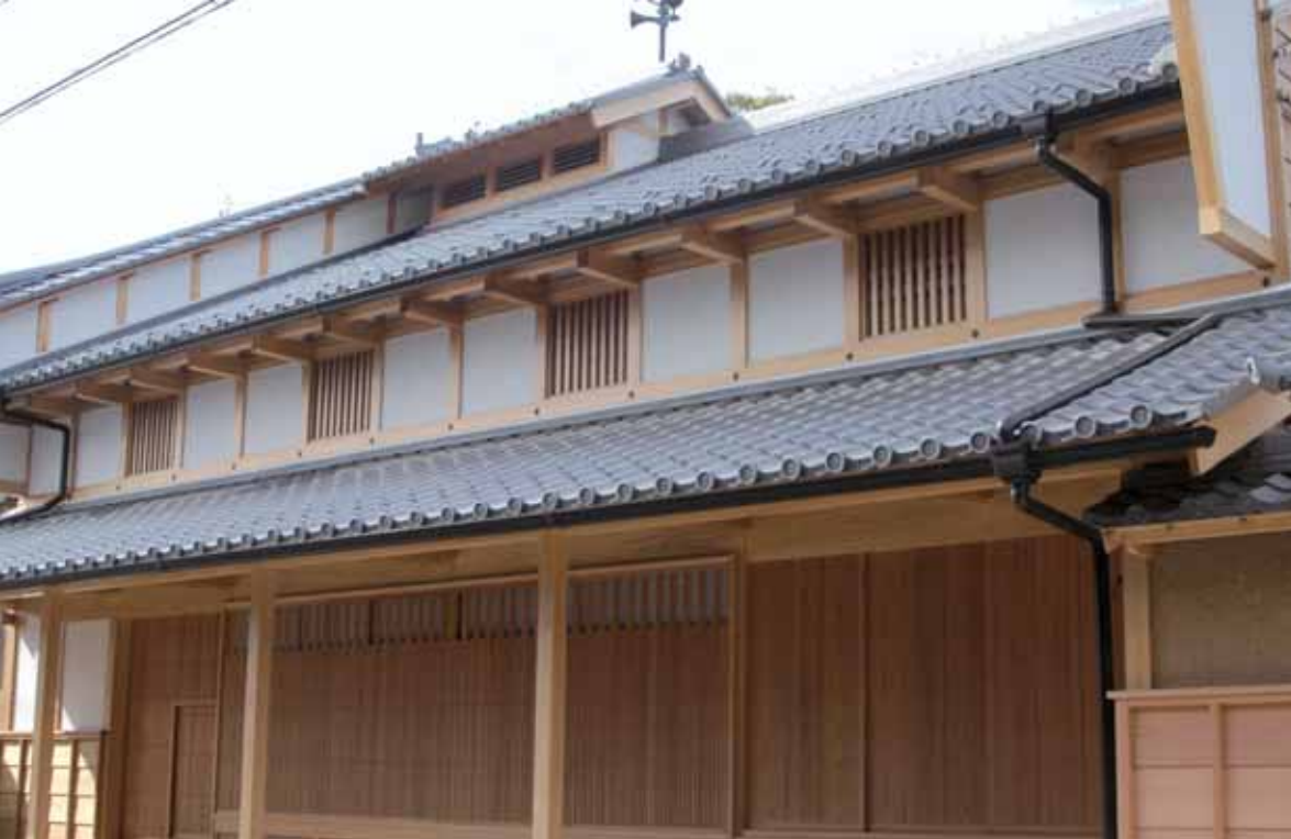
▲中山道鵜沼宿脇本陣の外観。建物は間口19.9m、奥行29.1mの大きさで、構造は木造つし2階建て。
