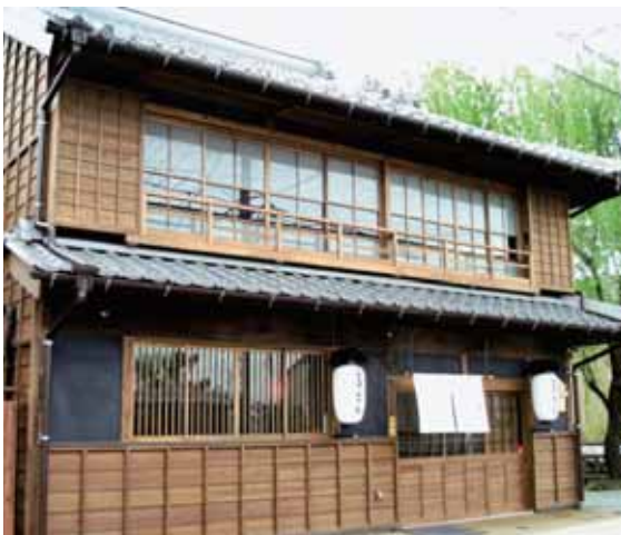
▲昭和46年まで菓子店として営業していた建物を改修した「宇留摩庵」。すぐ隣には大安寺川が流れます。
