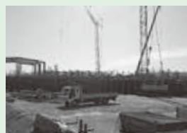
みなと小学校建設予定地 (3月26日 現在)
