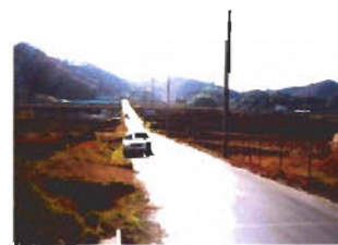
圃場整備 直線的な広い道路。排水路のコンクリート化や乾田化がすみ、生物にとっての水田環境は大きく変化した。
