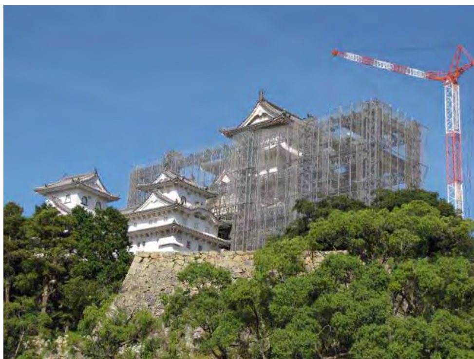
保存修理工事中の大天守
