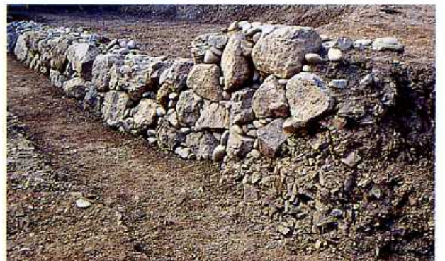
石垣検出状況（北東から）
