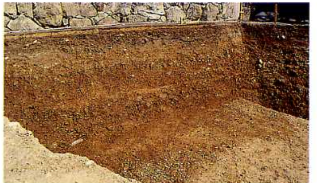
盛土造成状況（南西から）
