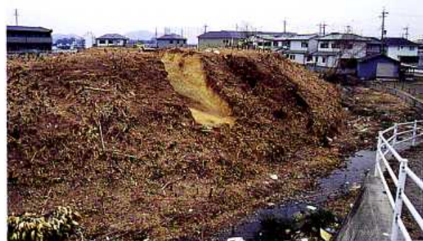
土塁断割り状況（北から）
