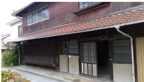
町家の外観（改修前）
