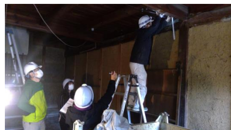
学生参加による改修作業
