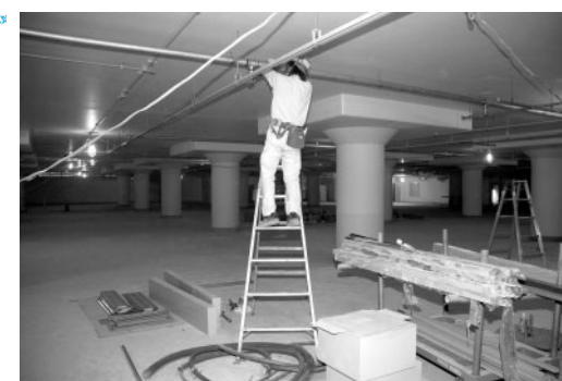
■着々と工事の進む一之江駅西口駐輪場
