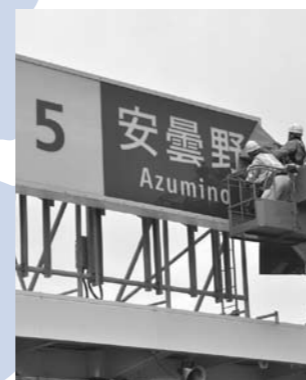
10月7日早朝にインターチェンジ料金所の表示板が付け替えられた。作業員が「豊科」のシールをはがし、「安曇野」の文字が現れた
