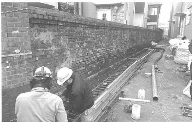
写真3 補修工事で地中の土台を補強
