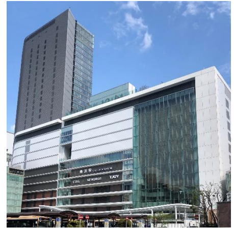
▲JR横浜タワー 外観写真
