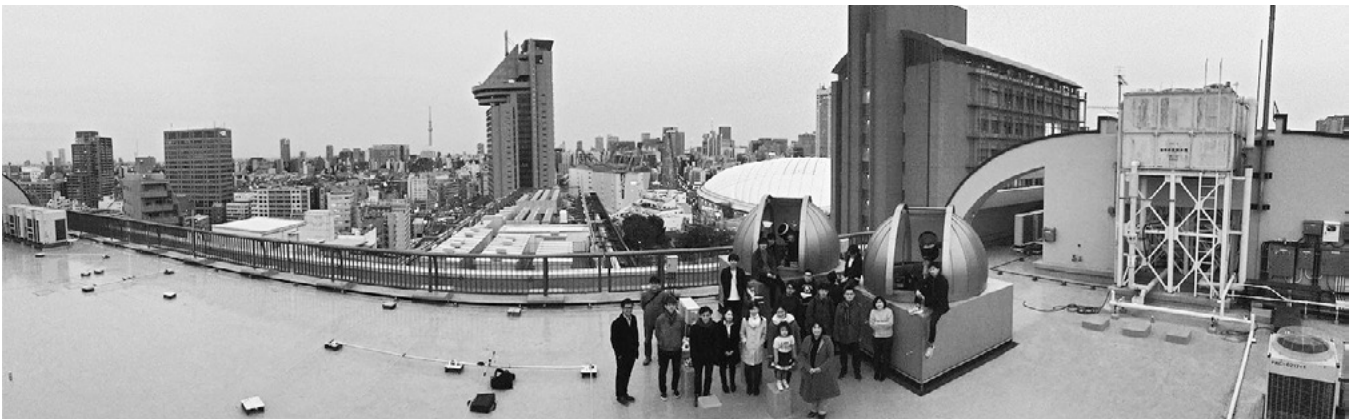
図2：6号館屋上のCAT/SCAT
